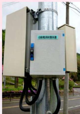
子局装置本体(無線受信機、アンプ)を保護するため柱などに避雷器を設置します。当社は、避雷器とオートコントロールブレーカが内蔵された自動電源耐雷装置や非常電源切替盤を設置する事が多いです。
