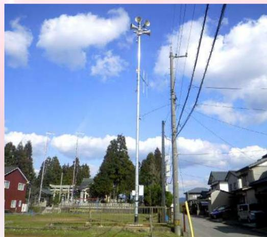
市町村に設置した「親局」からの電波を、市町村全域に設置した「屋外拡声子局(音声スピーカー・モーターサイレン)」が受信し、サイレンと音声放送により、緊急情報などをお知らせします。
