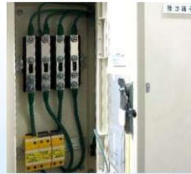
監視所の設備を直撃雷サージから保護するため電室の電源主幹部にVAJシリーズを設置し、接地極間の等電位化のため、接地SPDを納入させていただきました。
