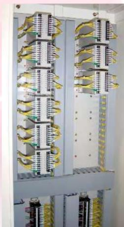
大学のような大規模建築の場合、避雷針などへの落雷が接地から回り込む接地雷サージへの注意が必要です。また建物が複数ある場合、建物間の接地電位差により落雷があった建物だけでなく付近の建物にも接地雷サージが波及する場合があります。当社では重要負荷があるフロアの電源主幹部に大容量電源用のVAJ型避雷器を、設備状況に応じて通信線や信号線にVNJ型、VTJ型避雷器をご提案しております。
