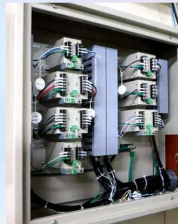
現地状況に適した耐雷対策のご提案や耐雷盤の設計をおこない、気象観測装置、放流警報設備(スピーカ・サイレン・集音マイク)、CCTVカメラ、電話回線(外線・内線)、漏水量計、水位計、地震計、監査廊照明、監視所～各ゲートとの信号線など雷サージが侵入する恐れのある設備に対策をおこなっております。
