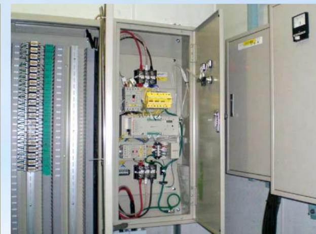
当社では現場調査による耐雷対策に注力しており、工場への対策実績は各地にあります。雷害の影響が大きくなるサーバー、インバータや直流電源装置に代表される電源機器、プラント運転の要となる計装機器の対策に関しては特に高い評価を頂いております。また、ITVカメラ、自火報、構内放送設備への耐雷対策についても多くの実績を有しています。
