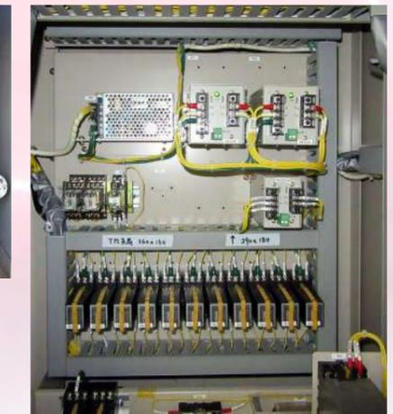
水関連処理設備ではテレメータ盤や計装盤の電源部、テレメータ通信線や現場機器からの計測信号に避雷器を設置します。また、現場側には計測機器の電源と信号線への設置もご提案しております。配線距離が長い場合は設備間の自営通信線や盤間の制御信号線にも避雷器を設置します。上記の対策箇所に加えポンプを駆動するインバータの耐雷対策が当社独自のご提案として高い評価を受けております。
