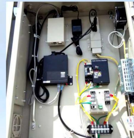
道路情報等の監視カメラは、屋外の高い位置に設置するため、雷害による機器の被害が非常に多いです。当社では、監視カメラの機器収容盤に避雷器とオートコントロールブレーカを内蔵しております。
