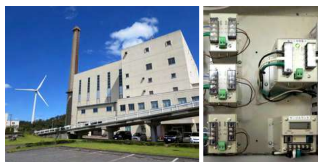
ごみ処理設備
