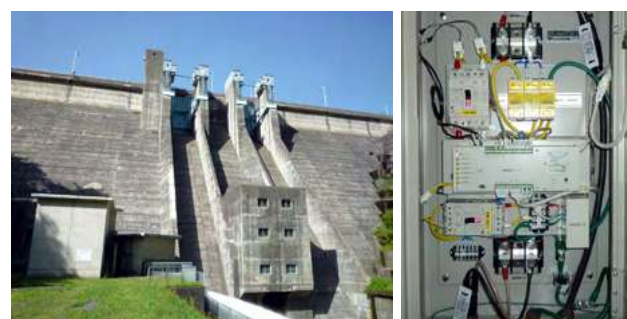
ダム管理設備
